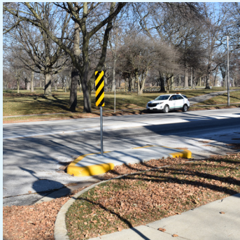
Extensión de la acera de concreto clavado
