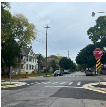
Extensión de la acera de concreto entero
