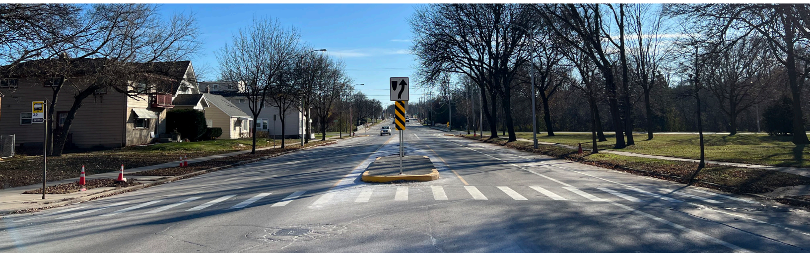
Isleta/Isla Peatonal de concreto
