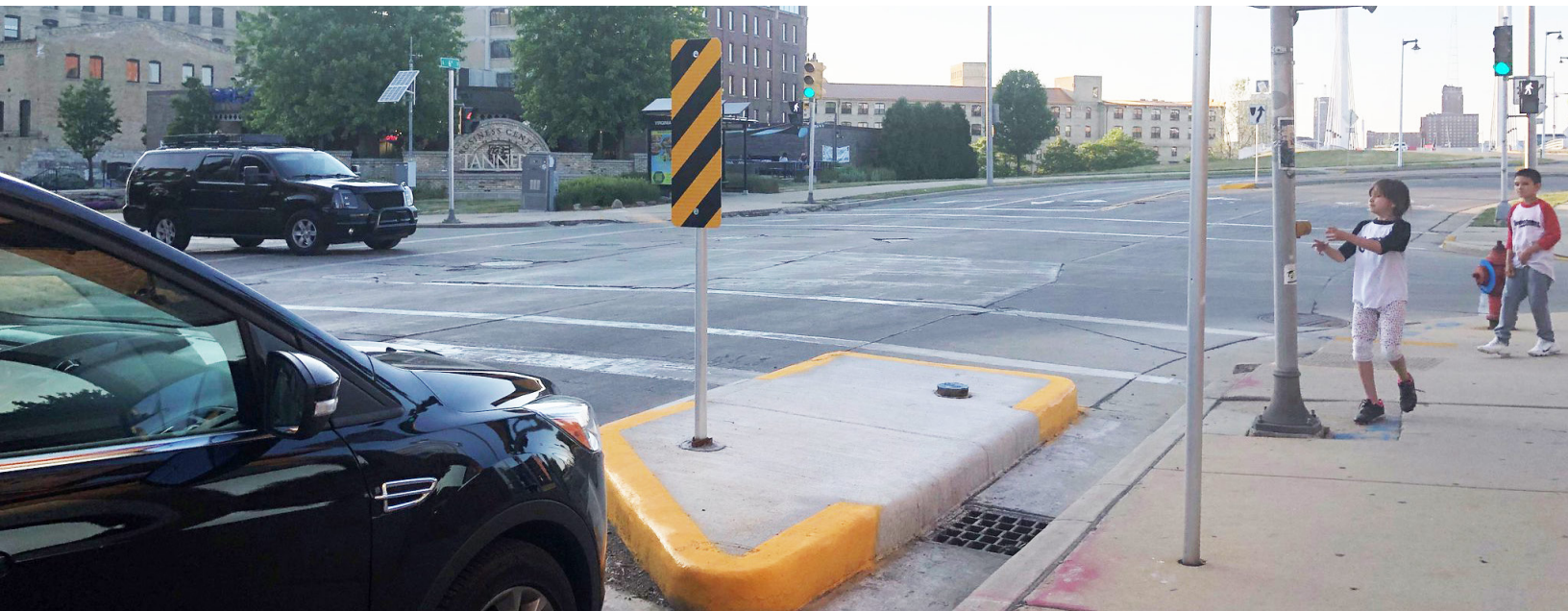
Extensión de la acera con concreto clavado en la calle S. 6th
