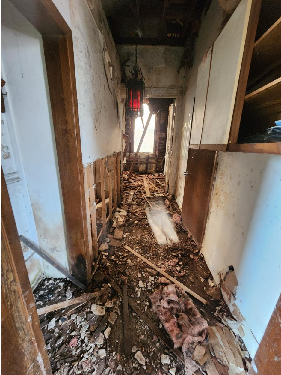
3 rd Floor Hallway
